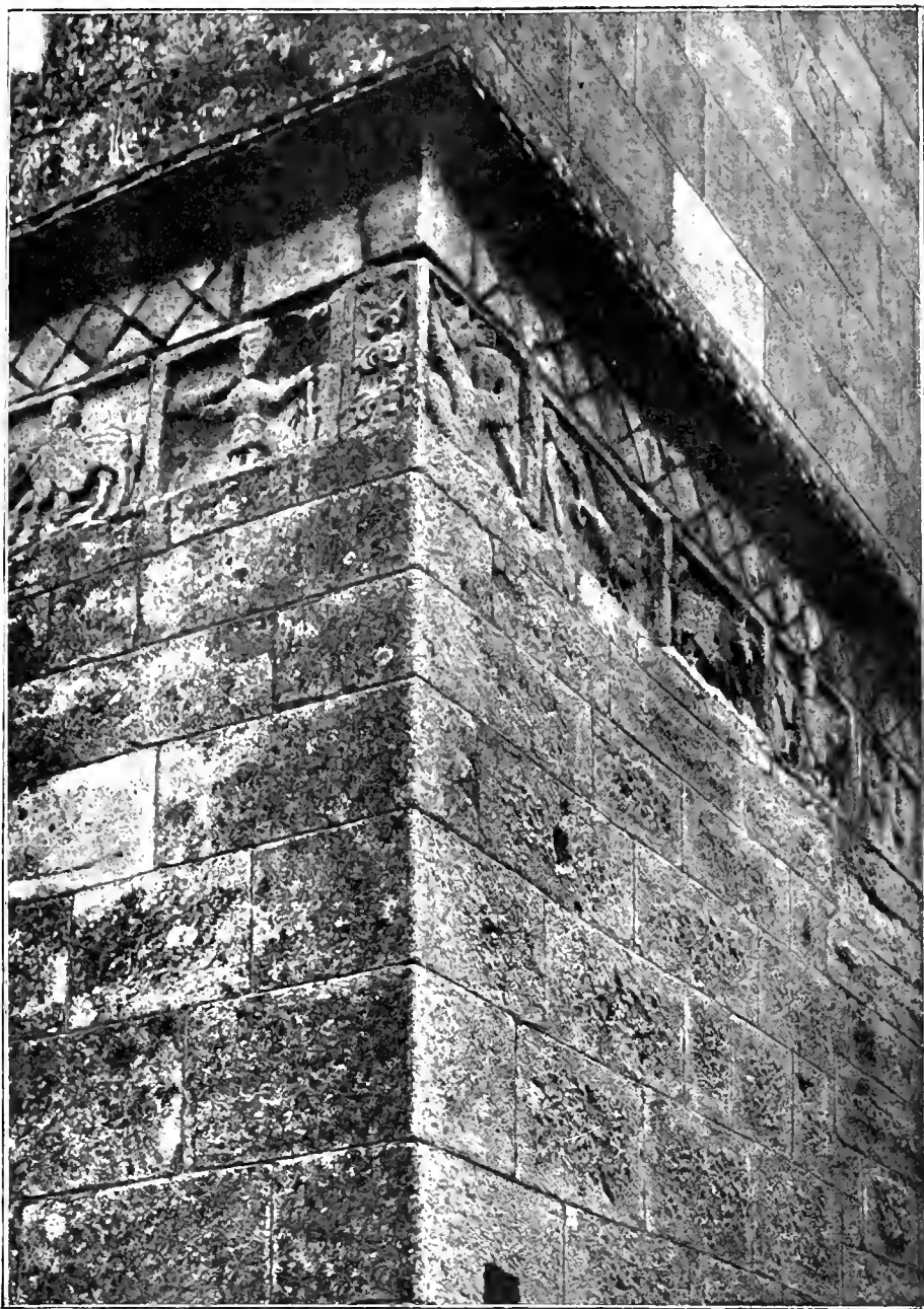
Tour de Saint-Restitut, appareil de la maçonnerie.
